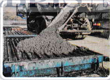
Fig. 7. Realizarea fundației din beton armat
